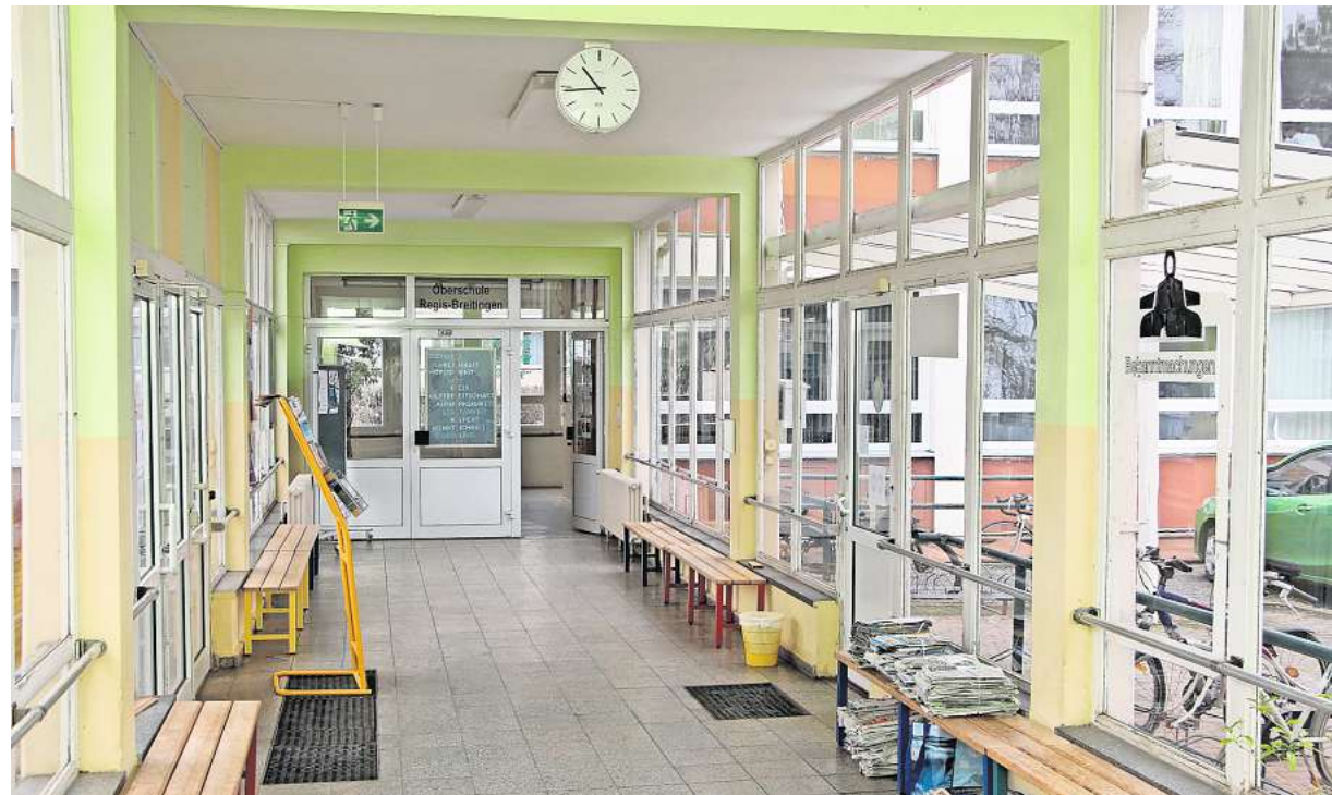
Regis-Breitungen hat Geld für die Sanierung der Oberschule eingeplant. Passieren an dem Gebäude wird in diesem Jahr voraussichtlich nichts mehr.
